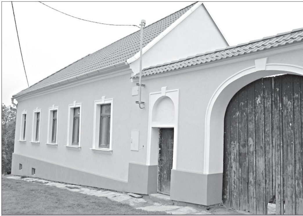
Rytmus a řád venkovské architektury dostal dům v Lukově po rozsáhlé rekonstrukci.
